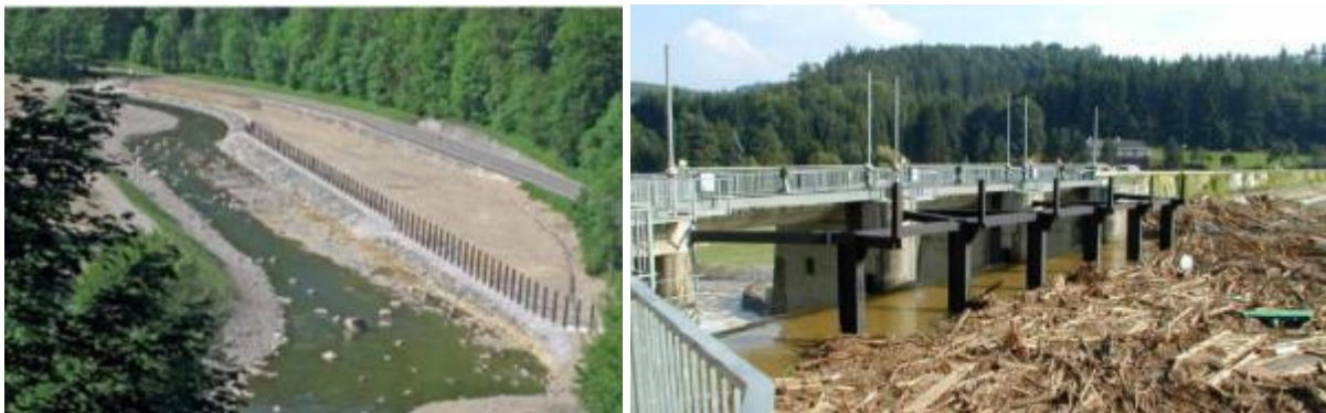
Figure 17 : Exemple de système de rétention a) peigne, b) masque amont (râtelier ou « visor »)
