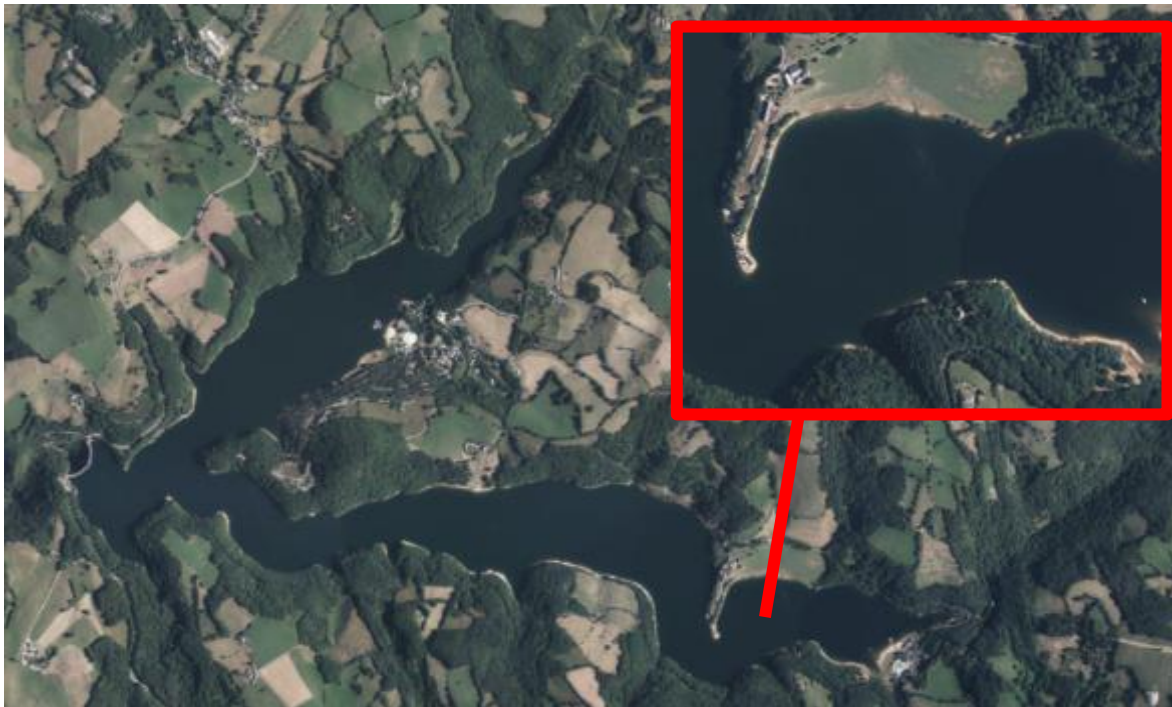
Figure 4 : Exemple de zone d'échouage potentielle sur une retenue sinueuse
