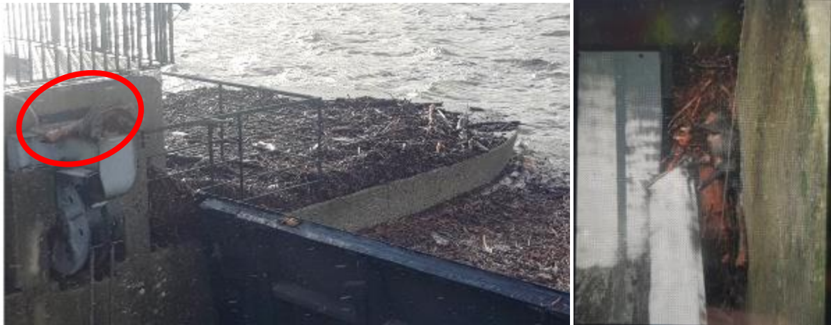
Figure 15 : Exemple d'accumulation de corps flottants par les effets des vagues et du vent
