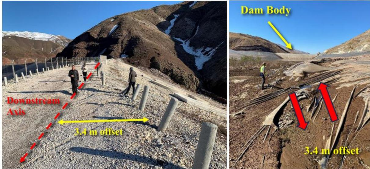
Figure 10 - Cisaillement de la crête du barrage – cisaillement et dégradation de la membrane dans la retenue [21]
