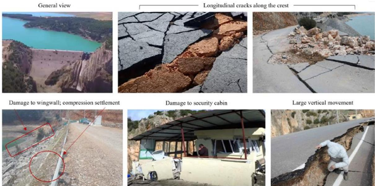
Figure 8 - Observations faites par les auteurs sur le barrage de Kartalkaya [30] et [29]
