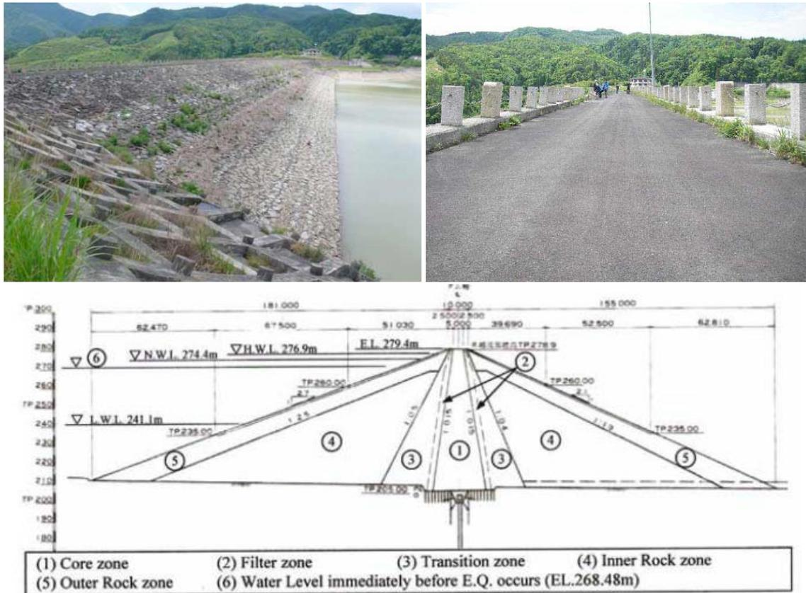
Figure 20 – Barrage en remblais d'Aratozawa ayant connu un séisme  $> 1 g$  au sol, extrait de USSD (2014) [15]
