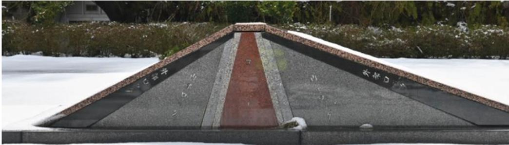
Figure 13 - Maquette du barrage de Oya présentant le zonage du corps du remblai
