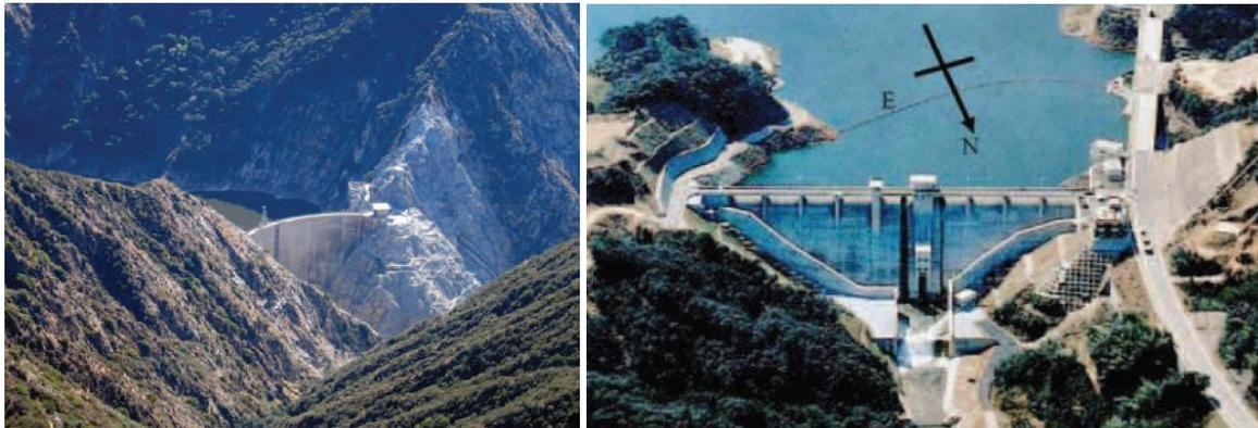
Figure 19 – Barrage voûte de Pacoima (à droite, USA) et barrage poids de Kasho (à gauche, Japon) qui ont tous deux connus des accélérations en crête > 2 g selon Nuss [13]
