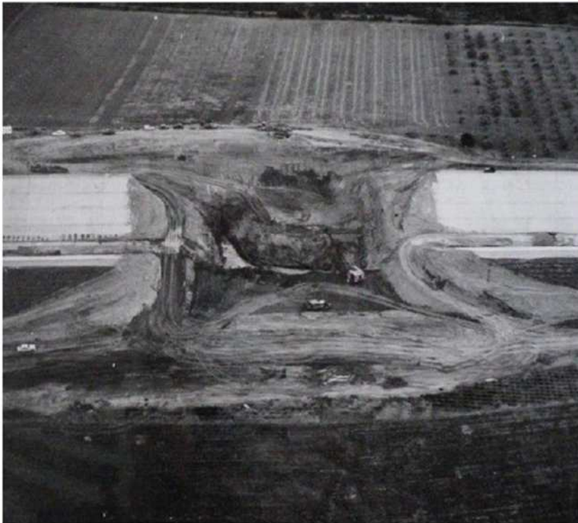
Photo 13 : Terrassement au droit de l'accident Paillerol (19/12/1962).
