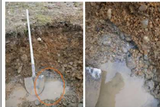
Photo 2 & 3 : Zone humide après terrassement.
