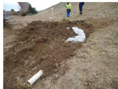
Photo 4 : Mise en place d'un drain (2013).
