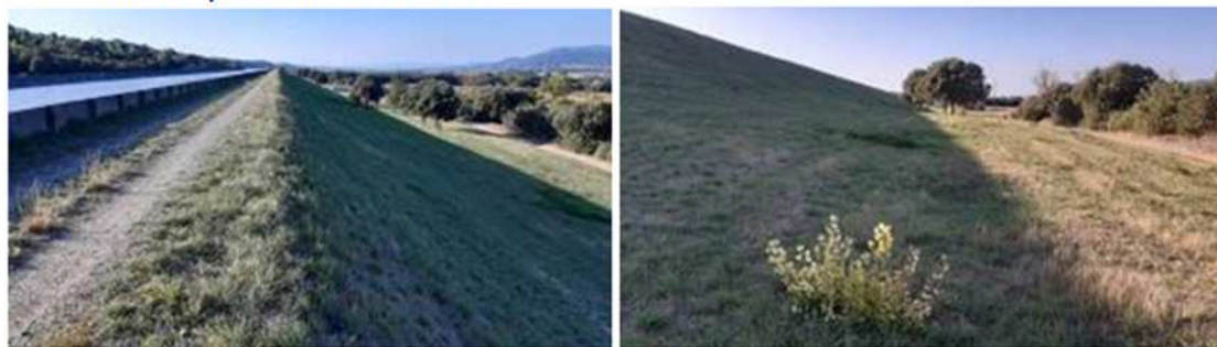
Photo 12 (VTA GC - 2021) : Talus au Pk 17,00 RD – Doline en pied de talus RD
