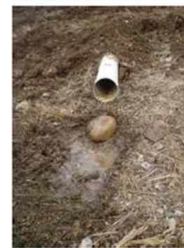
Photo 5 : Sortie de drain (2013).
