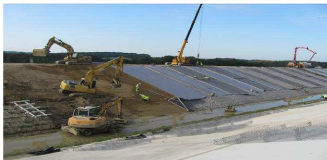
Photo 1 : Travaux de réhabilitation de la cuvette hydraulique du canal d'Amenée seine
