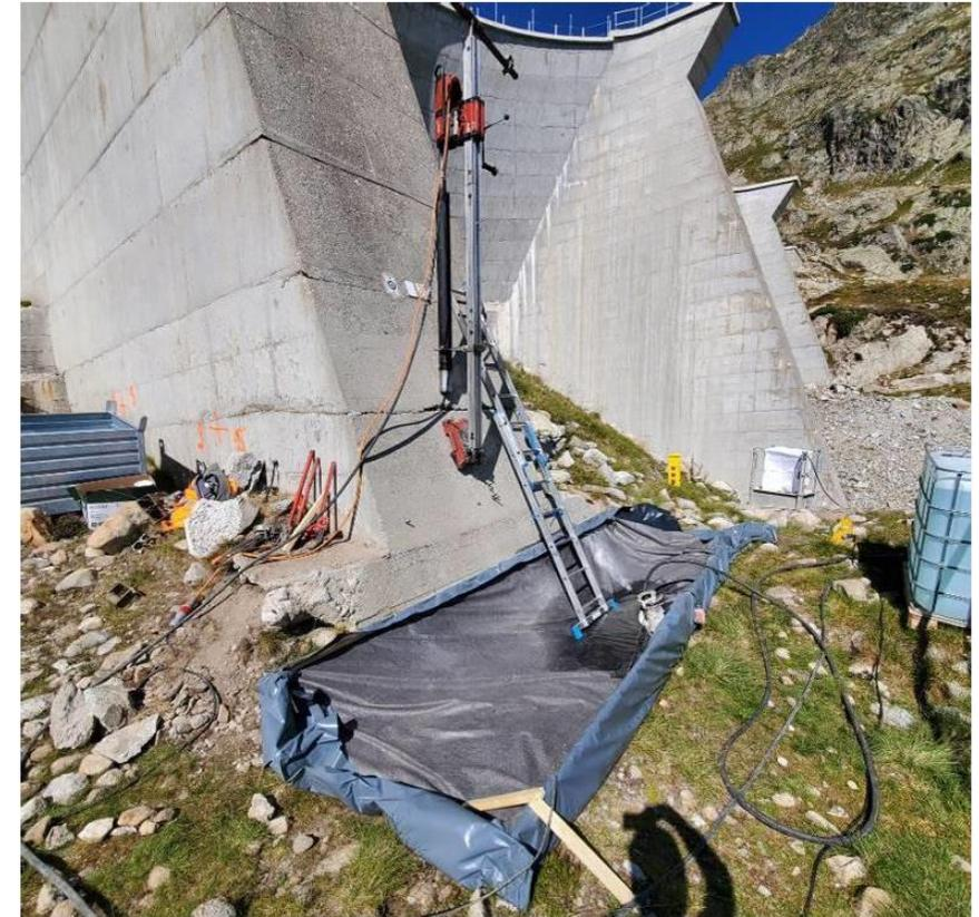
*Mise en station du forage vertical au contrefort C7*
