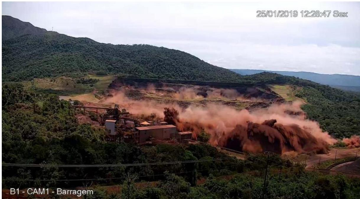
Figure 4: rupture du barrage de Brumadinho
