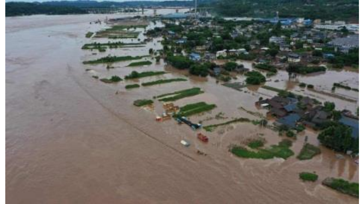
La digue en CFRD s'est rompue
