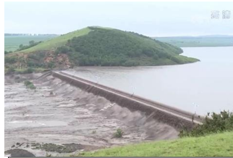
Xinfa dam (China) rupture par surverse (juillet 2021)
