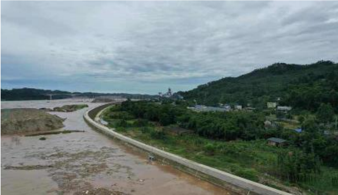
La digue en CSGR a résisté aux crues
