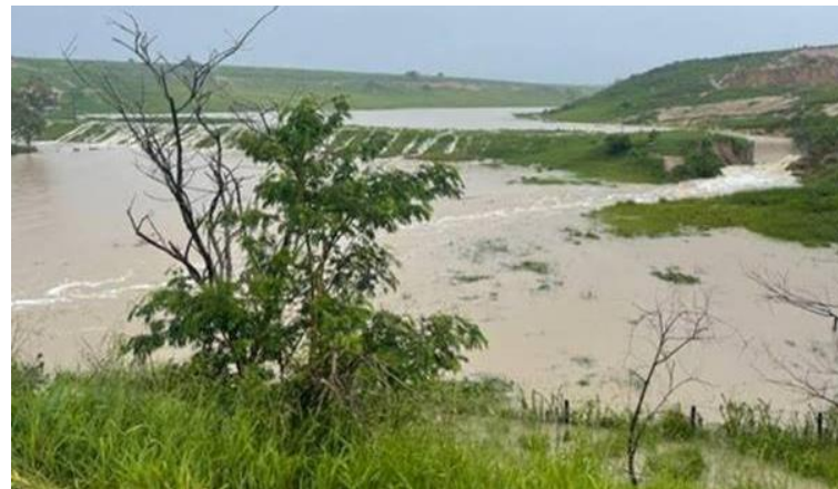
Igua dam – Brazil (Décembre 2021)
