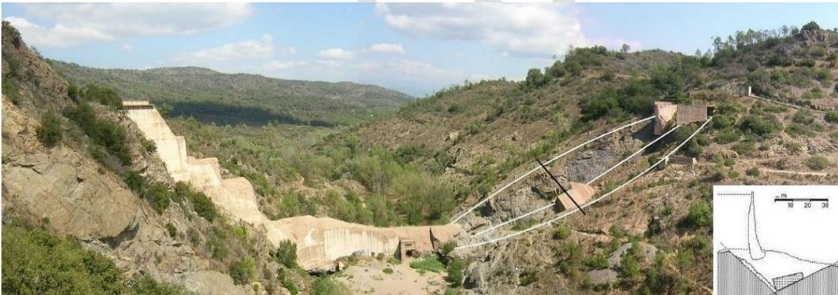
Figure 5 : Exemple de défaillance structurelle – Ruine du barrage de Malpasset
