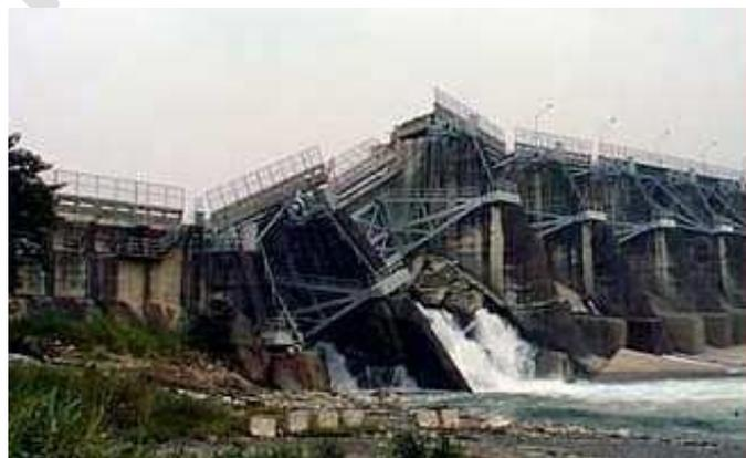
Figure 8 : Agression sismique - Barrage de Shih-Kang (Taïwan) - Séisme du 21 septembre 1999
