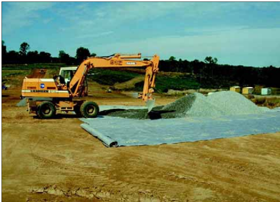
▲ 9 - Géotextile anticontaminant sous un drain horizontal en graviers (texte p. 79).
