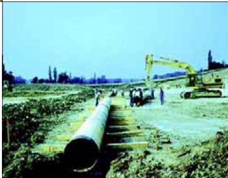
◀ 17 - La tranchée est remplie de béton.
