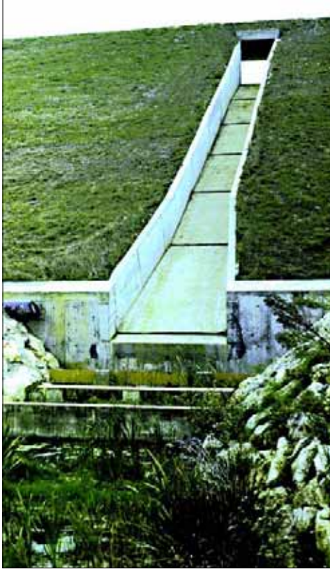
◀ 19 - Déversoir à entonnement frontal, coursier posé sur remblai et dissipateur d'énergie (texte p.96).
