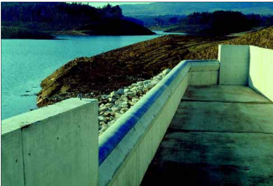
▼ 20 - Partie déversante d'un déversoir à entonnement latéral.
