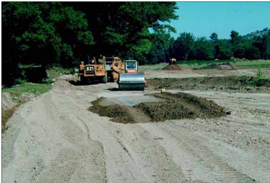
▲ 3 - Planche d'essai d'un très petit barrage (au fond le compacteur à rouleau lisse et une décapeuse qui amène la terre depuis la zone d'emprunt (texte p. 102).
