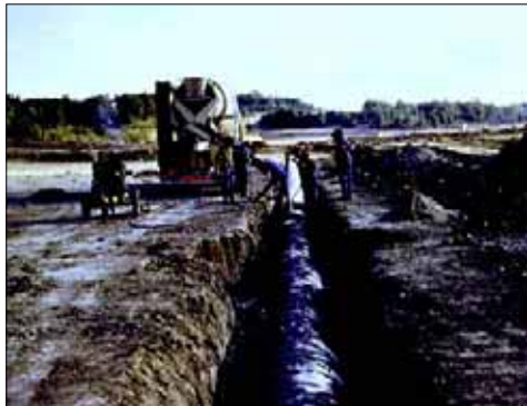
18 - Le bétonnage est terminé. ▶
