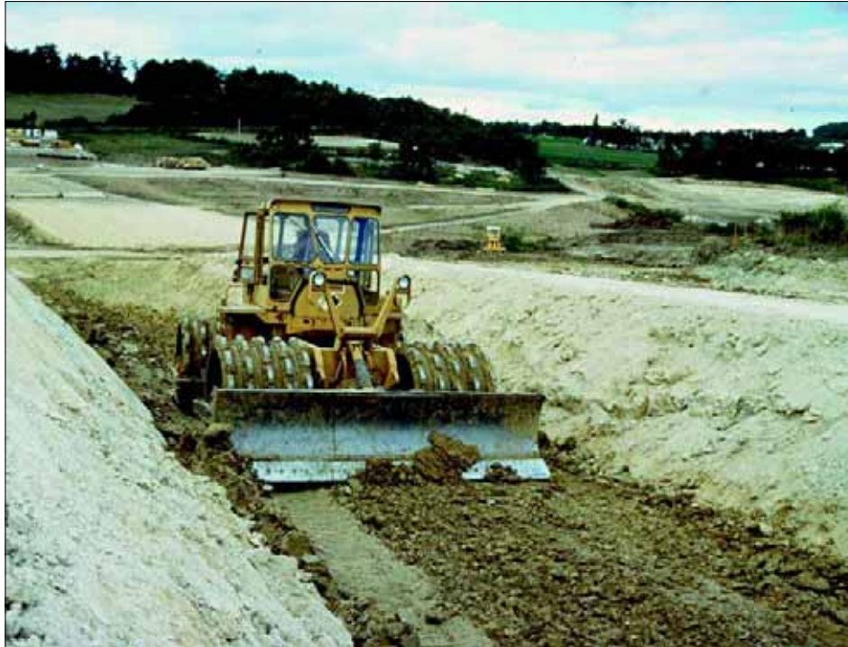
▲ 1 - Compactage d'argile dans la clé d'étanchéité (texte p. 71).
