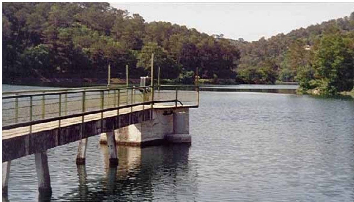
Photo n°3 : Plate-forme de manœuvre de la vanne de demi-fond et lac de Carcès
