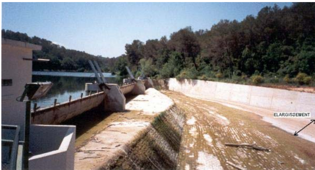
Photo n°5 : Vannes-clapets et coursier de l'évacuateur élargi côté rive gauche lors des travaux de mise en conformité
