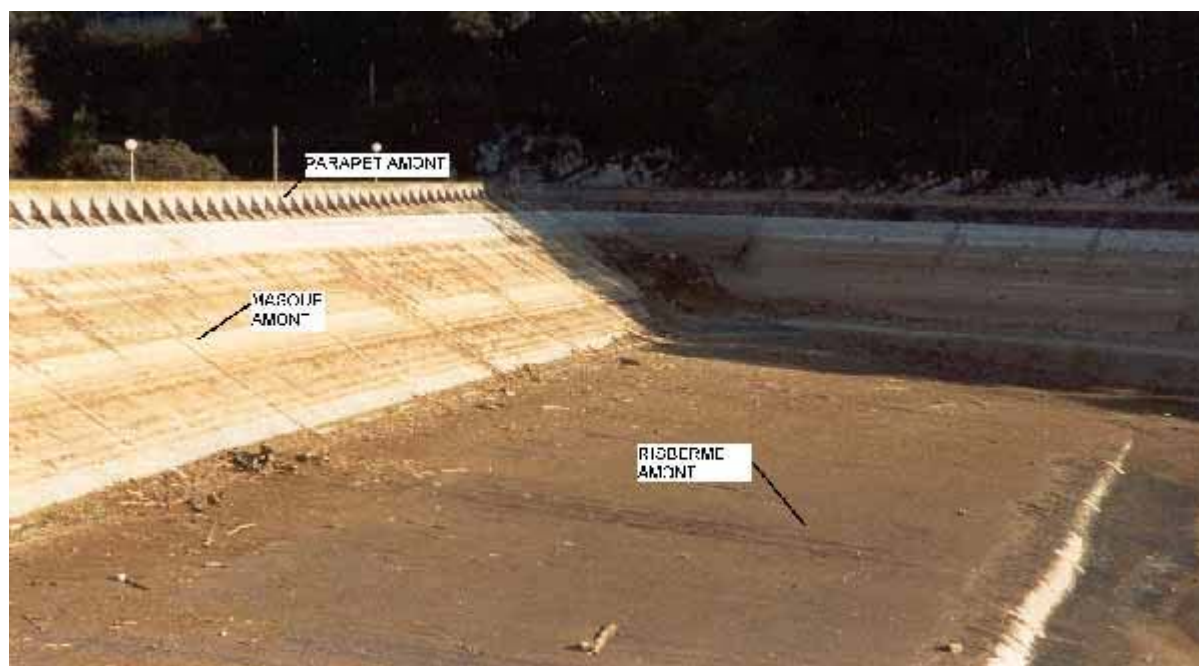
Photo n°2 : Vue amont rive droite lors de la vidange décennale de 1999
