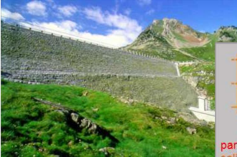
Avec un enrochement ayant  $\Phi=37^\circ$  pour 100kPa
