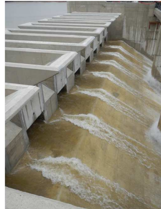
Mise en service des pertuis provisoires (photo du 04/03/2015)
