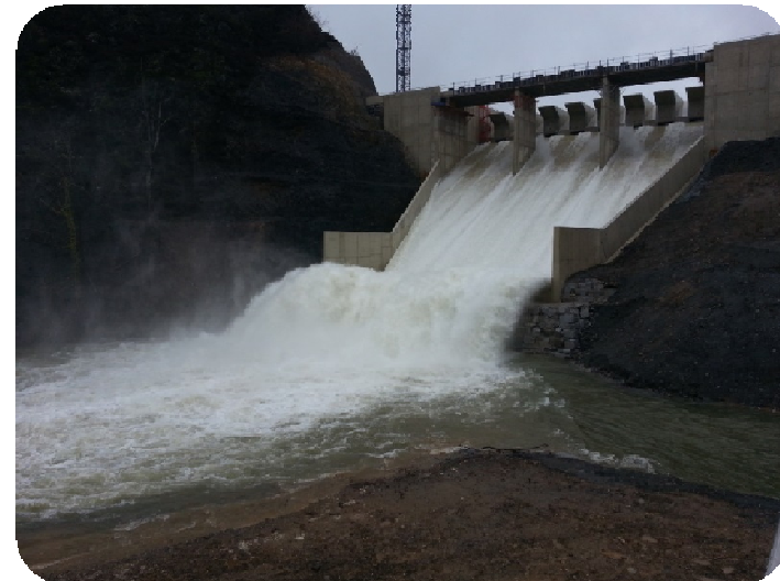
Mise en service des pertuis provisoires (photo du 04/03/2015)
