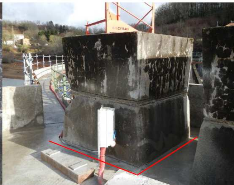
Plan de découpe inférieur (Découpe tirant à cœur estimée achevée le 08/01/2015 à 14h)
