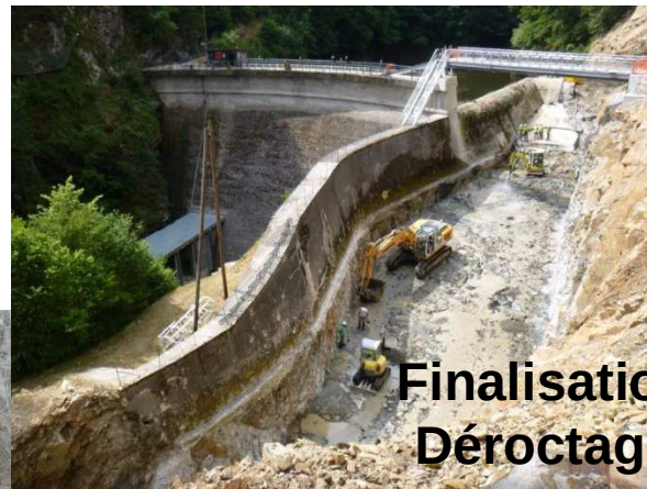
Stabilisation mur déversoir
