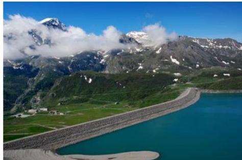
Propriétaire / Exploitant : EDF Hauteur : 95 m Volume de la retenue : 320000 milliers de m<sup>3</sup> Rivière : CENISE Type Barrage : Enrochements Longueur : 1400 m (...)
