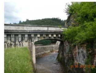
Photo 2 : Passage sous barrage
