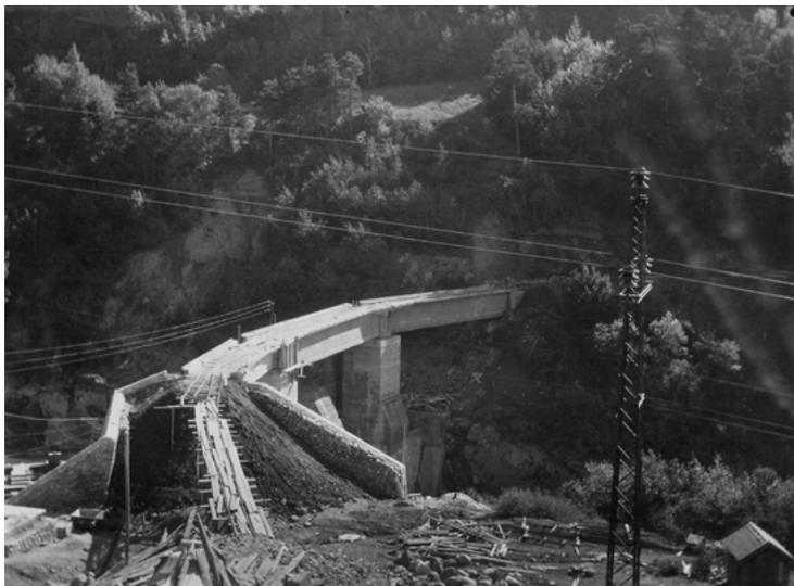
Le 12 octobre 1934, les travaux du pont routier sont bien avancés. Les travées sont en place, les culées achevées et en cours de remblaiement. A noter l'utilisation (alors très courante) d'une voie de chantier à écartement sub-métrique.
