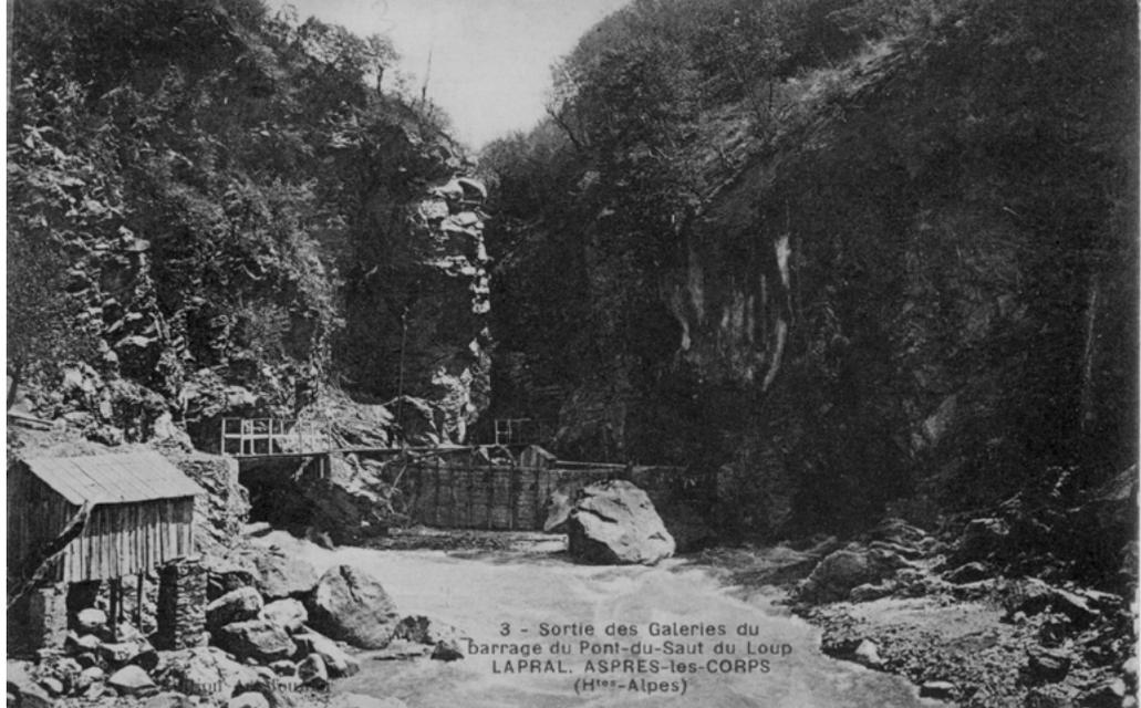
*Il s'agit bien entendu des deux galeries de déviation (provisoire) des eaux du Drac, qui ont permis la construction du barrage, complétées par le batardeau (provisoire) en pieux et planches que l'on aperçoit au fond. La cabane au premier plan faisait sans doute fonction de remise.*
