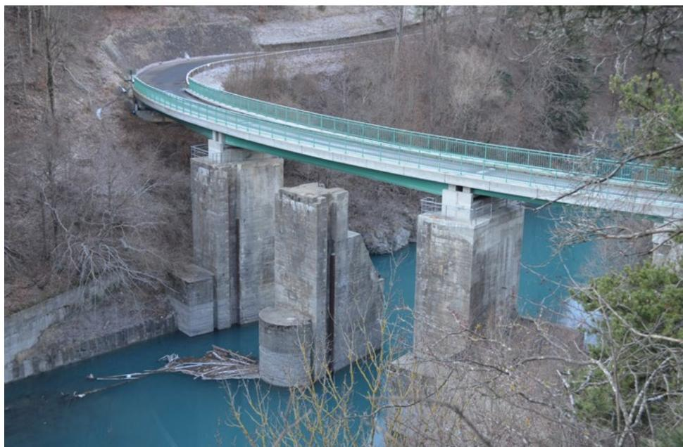
Voici l'ex-barrage dans sa fonction actuelle de (faux) pont-barrage. Vue prise depuis la rive droite le 30 décembre 2016. On voit bien que les piles d'origines ont été renforcées, et deux rainures-guide des vannes Stoney apparaissent nettement. A noter enfin que la pile centrale est maintenant inutilisée, et que les dépôts affleurants traduisent un engrèvement total.
