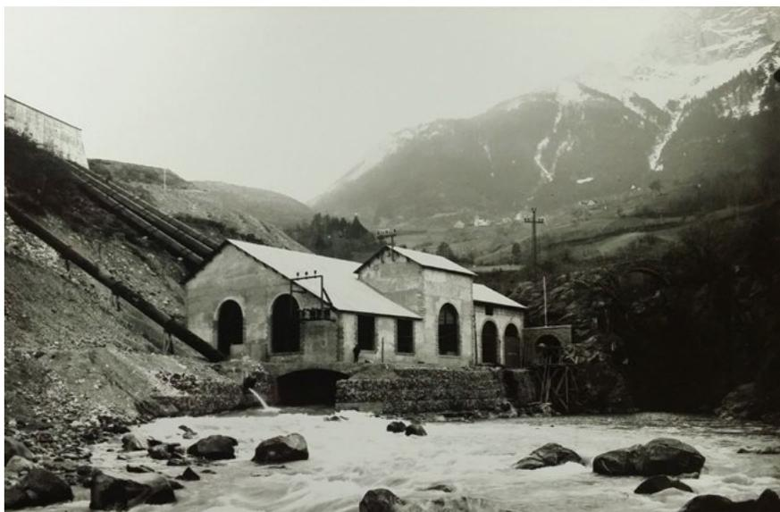
Vue de détail de l'usine, photographiée depuis le canal de restitution. La partie centrale de la construction, surélevée, laisse supposer qu'il s'agit de la zone allouée aux transformateurs et à leur dépotage. En haut à gauche, la chambre de mise en charge, d'où partent le déversoir (au premier plan, avec un débit réduit) et les trois conduites forcées (en arrière-plan).
