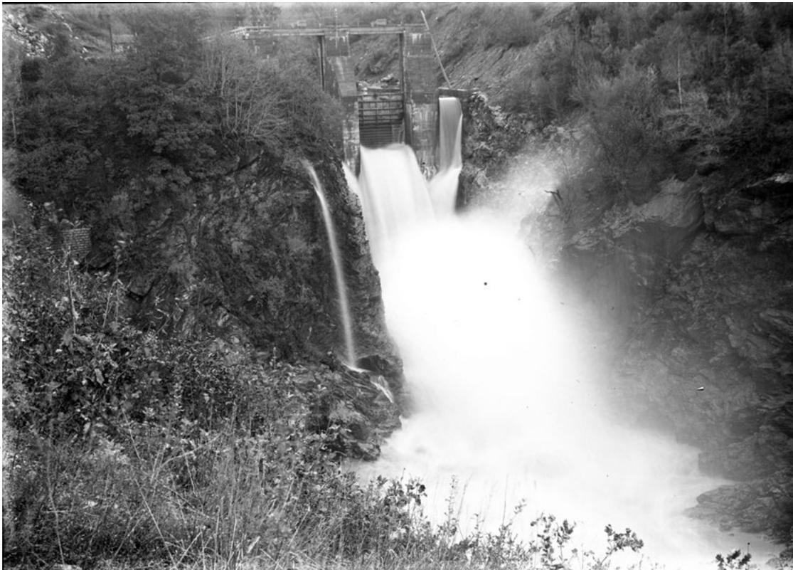
L'ouvrage en service lors des grandes crues de 1928. Un débit impressionnant, avec débordement sur la droite. On ne voit qu'une seule vanne, la seconde étant masquée. A noter la passerelle posée sur les piles et accessible par une seule échelle depuis la rive gauche. Sécurité toute relative...
