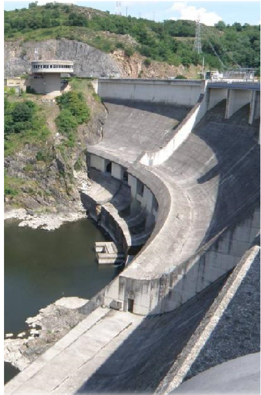
Barrage de Villierest ©BRL Exploitation – Anthony Lysimaque
