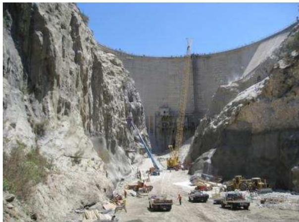
Figure 2 : Photos du barrage Big Tujunga en réparation.
