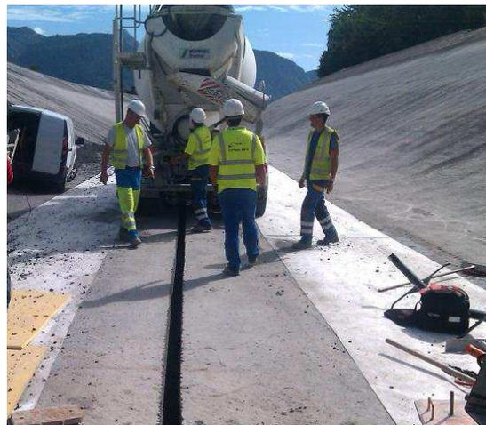
Figure 10 : Atelier d'installation des fibres optiques de mesure des déformations
