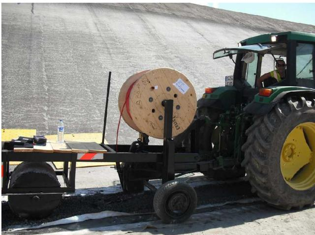
Figure 9 : Atelier d'installation des fibres optiques de mesure de la température
