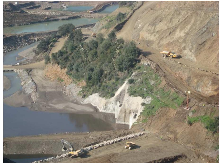
Batardeau provisoire & portail amont des galeries de dérivation provisoire
