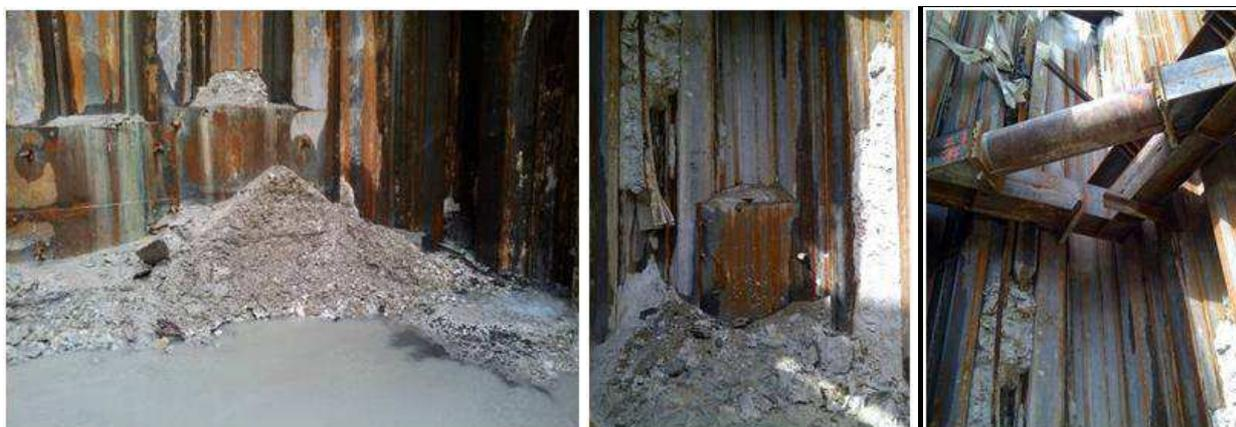
*Photos 8 et-9 : Renforts en béton immergé dans l'enceinte passe rive droite*
