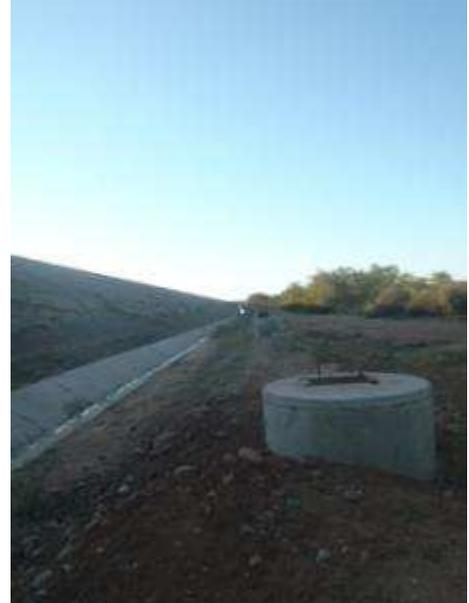
*Photo 4 : Photo des puits de décompression mis en place en pied aval*
