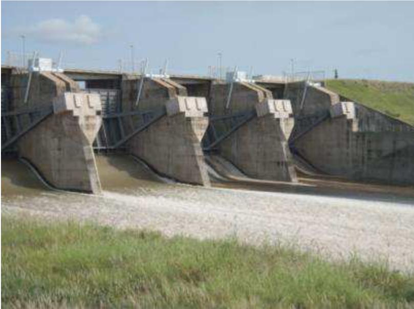
*Photo 3 : Photo des vannes de l'évacuateur de crues principal du barrage de Massingir (vue de l'aval)*
