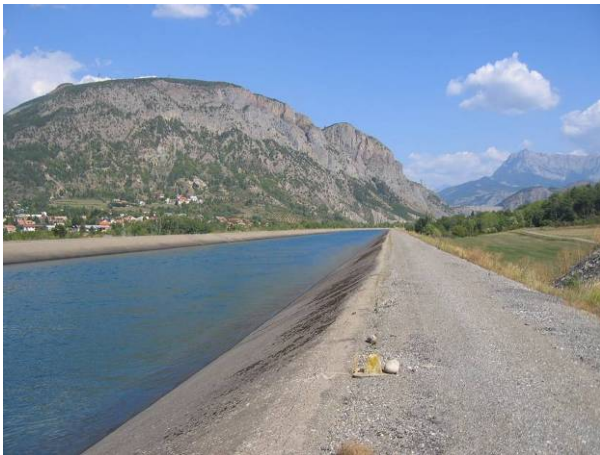
Vue rive droite largeur 4 m
