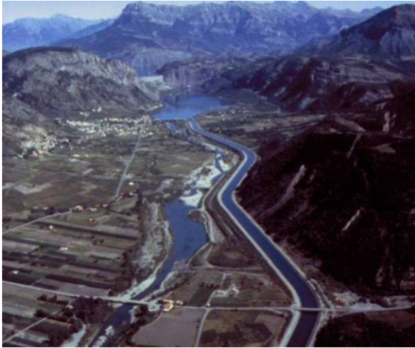
Le canal de Curbans vu vers l'amont avec, au fond, la retenue d'Espinasse et le barrage de Serre-Ponçon
