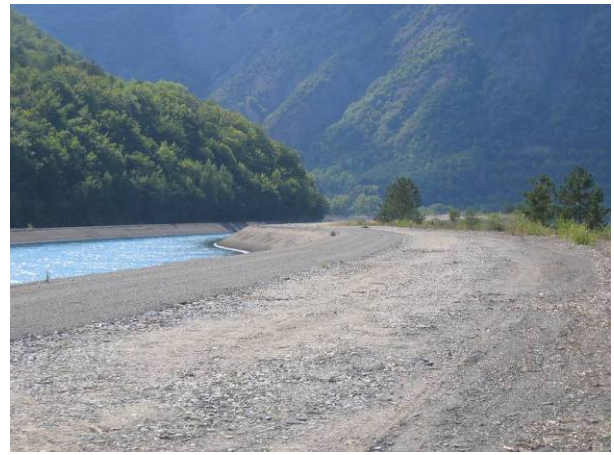
Vue rive droite côte élargie
