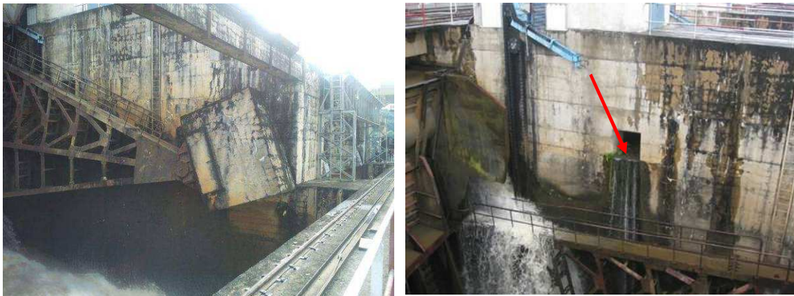
Graphique 9 : Vue de deux piles de l'évacuateur de crue
