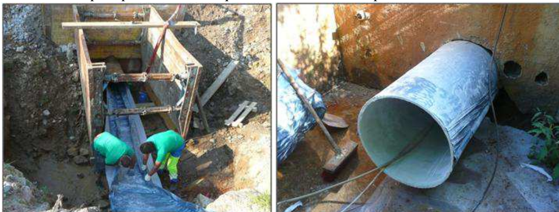
Graphique 3 : Réhabilitation de la conduite de fond par chemisage continu (de gauche à droite : traction de la gaine dans la conduite et extrémité aval de la gaine polymérisée).
