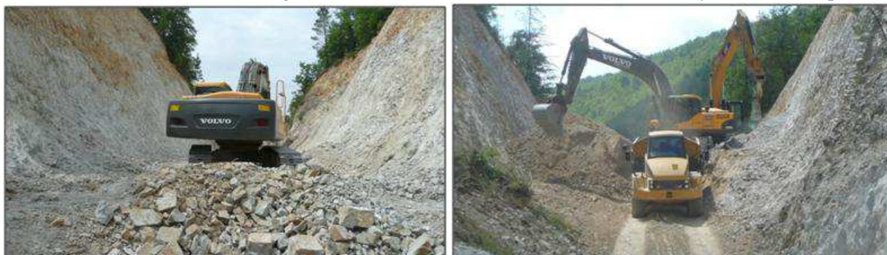
Graphique 5 : Excavations du fond du chenal de l'évacuateur de crues (de gauche à droite : déblaiement du fond après tirs à l'explosif et reprofilage des pieds de talus au BRH)
