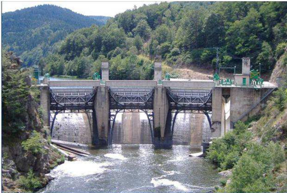
Photo 1 : Vue aval du barrage de Poutès
